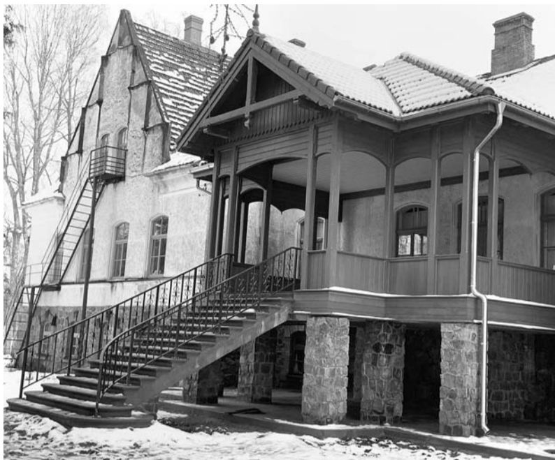
Mēru muižas terase pēc pārbūves.
