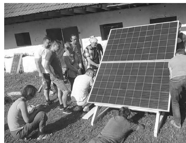
Projekta dalībnieki izgatavo un apmāca uzstādīt saules paneļus.
