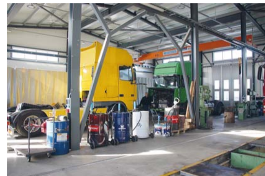
Jaunatklātais kravas automašīnu servisa un rezerves daļu tirdzniecības centrs „RZ Autocentrs”
