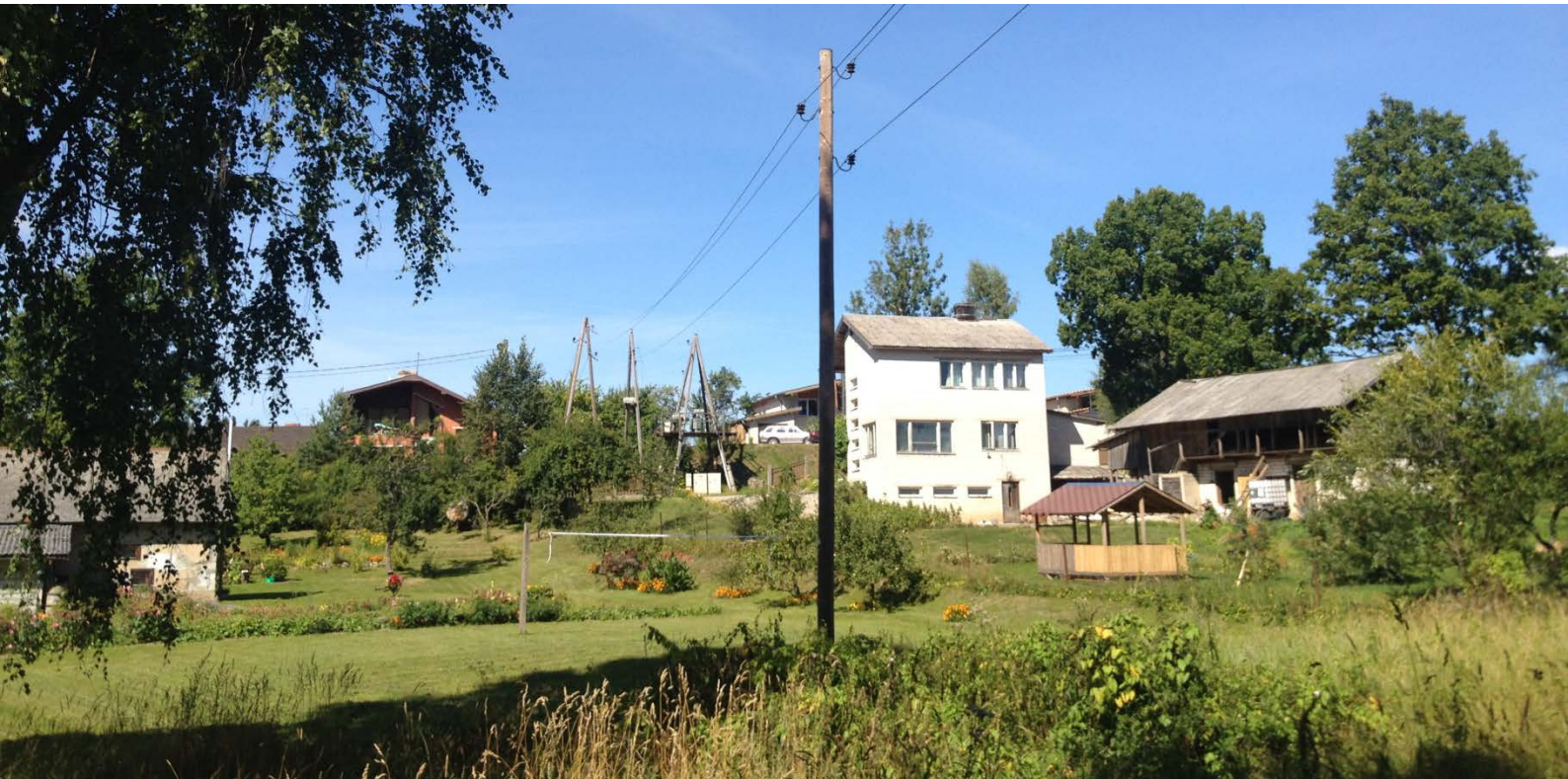
8.attēls. Esoša 20 kV elektropārvades līnija
