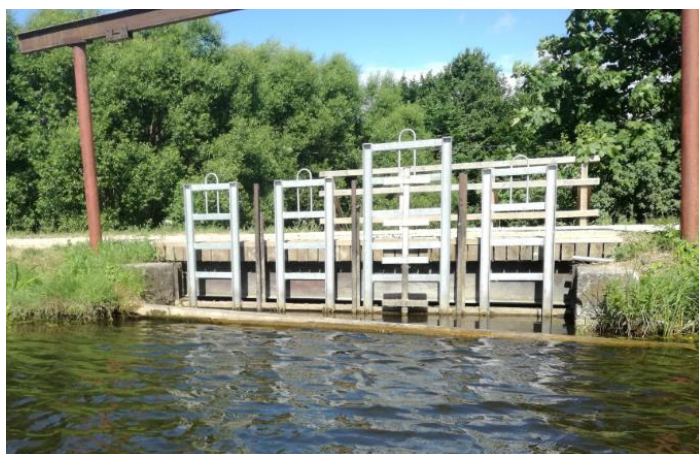
15. un 16. attēls. Tiltlejas ezera slūžas un ūdens līmeņa augstuma atzīme
