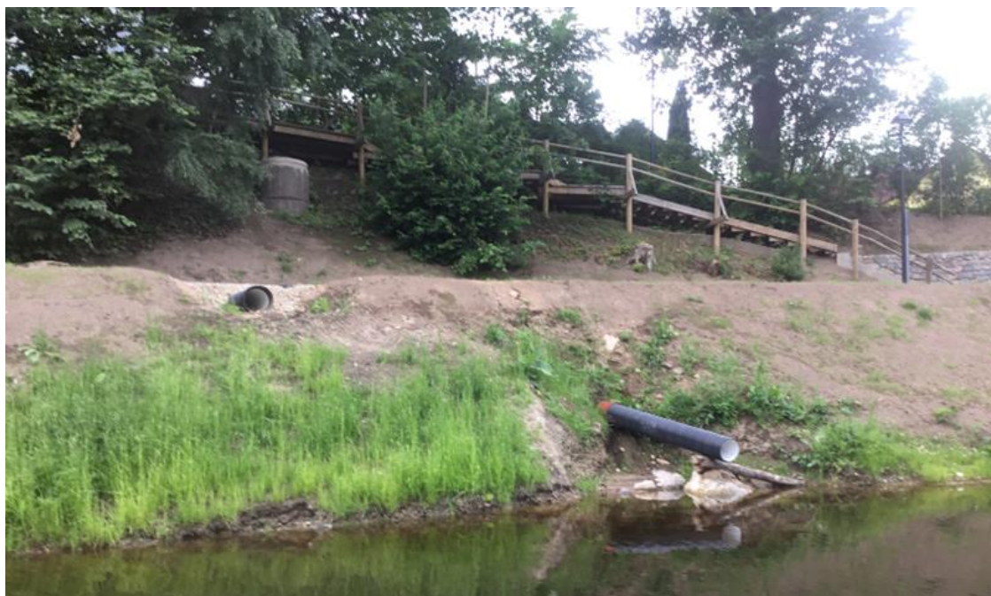
16.attēls. Potenciālās ūdensaugu aizauguma vietas Vidusezerā – vietās, kur no jauna ierīkotas notekcauruļu ieplūdes vietas
