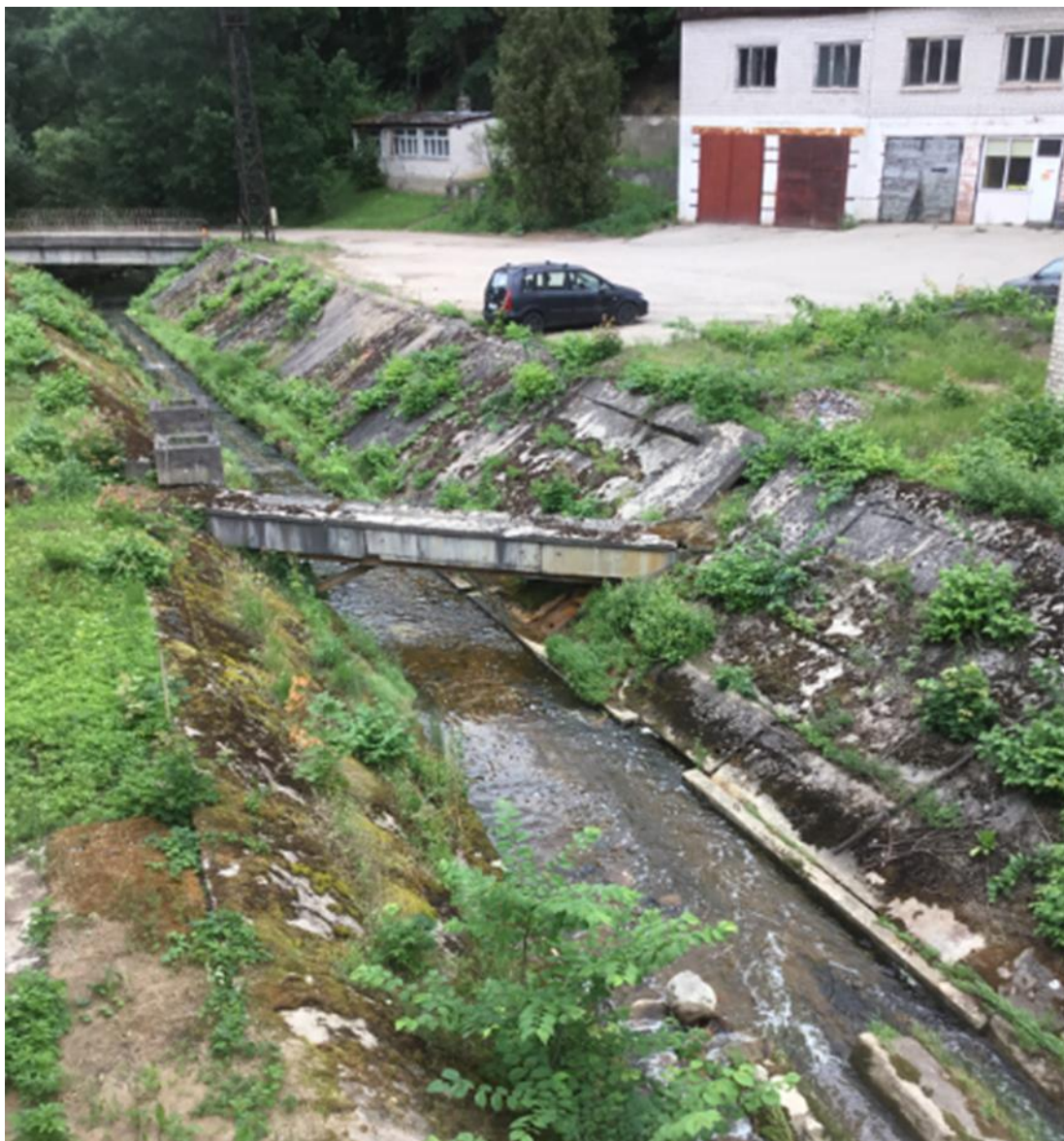
13. attēls. Vēsturiski izbetonētā Abula upes daļa Smiltenes pilsētas centrā lejpus Vidusezera dambja
