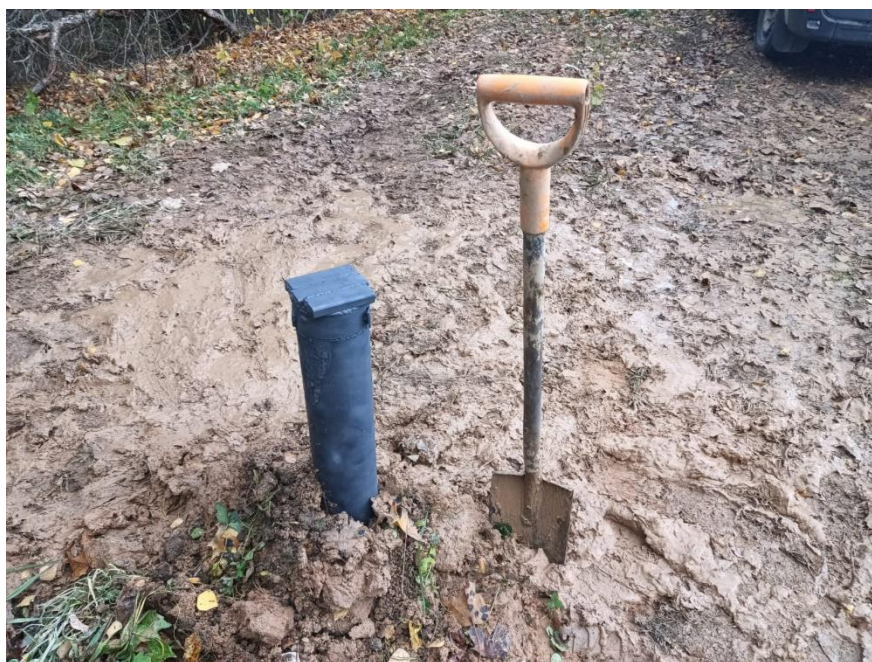
17. attēls. Hidroģeoloģiskā urbuma augšējā atvere.
