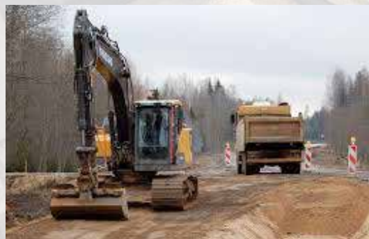
Ceļu būve, SIA "8C8R".
