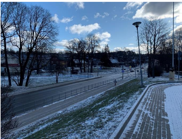
3-17. ATTĒLS. GAUJAS IELA JEB VALSTS REĢIONĀLĀ AUTOCEĻĀ P27 VIRZIENS
