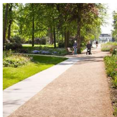
S2. Grants, irdenais segums ar plākšņu segumu gar vienu sānu gājēju plūsmu zonās
